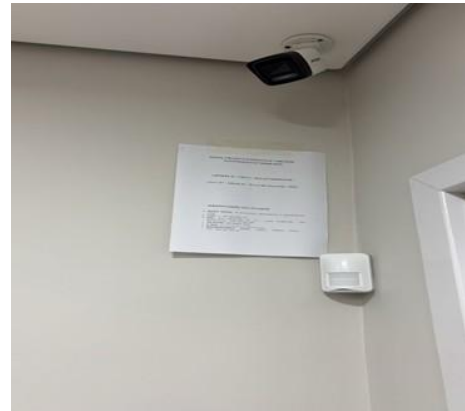
Figura 8 – Câmera Bullet Varifocal de videomonitoramento em operação durante a PoC
